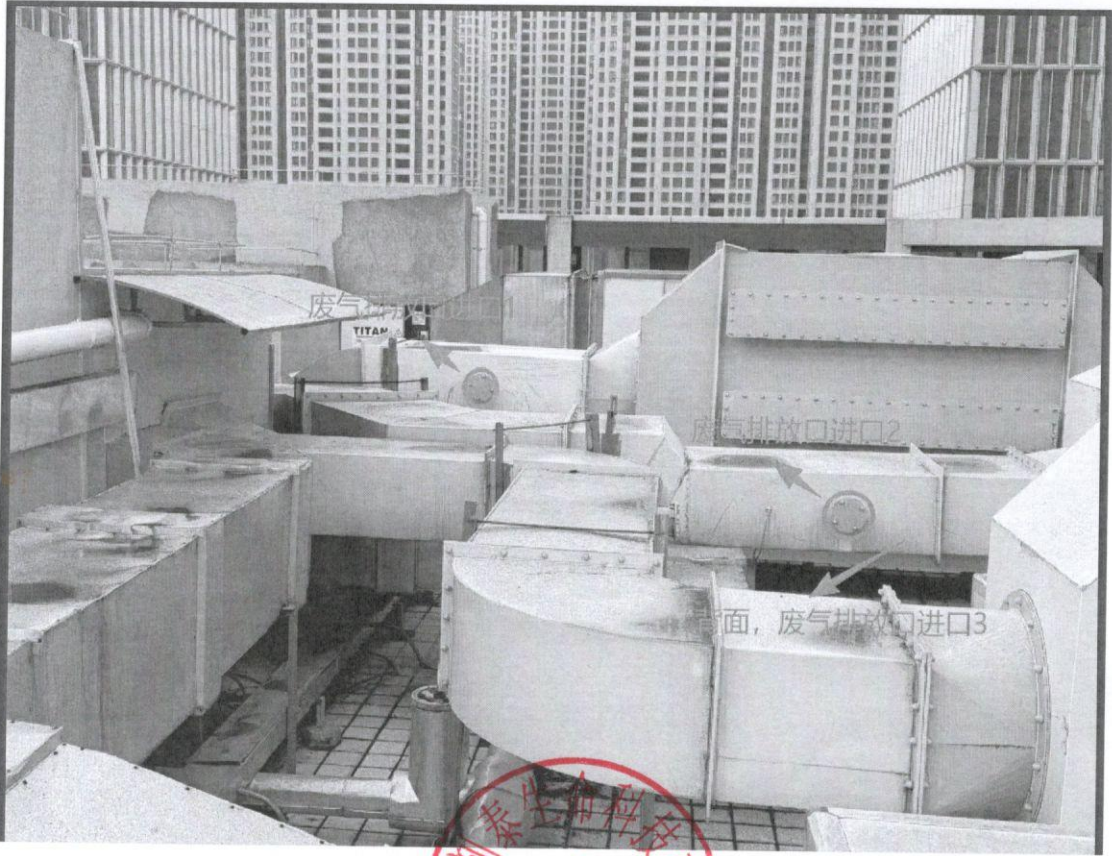
附件 2：楼顶三套废气处理设施总排气管及检测口位置
